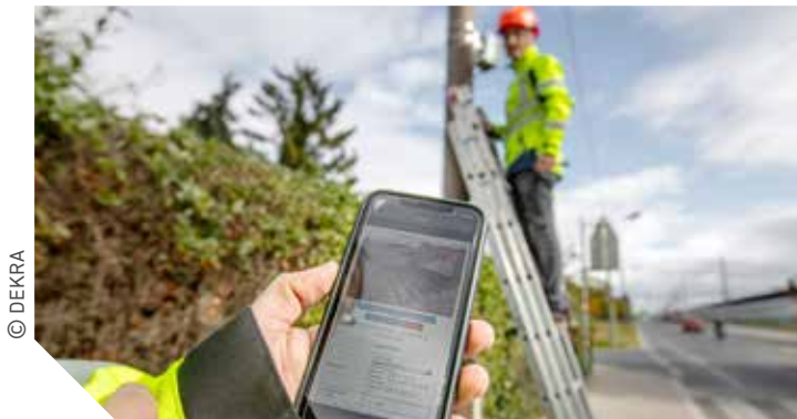
Verkehrsforscher des AIT montieren die Mobility Observation Box, die bis zu zehn Tage lang mobil und anonymisiert hochauflösende Verkehrsdaten erfasst.
